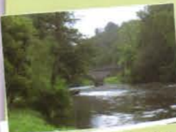
Ancien Pont sur le Taurion
